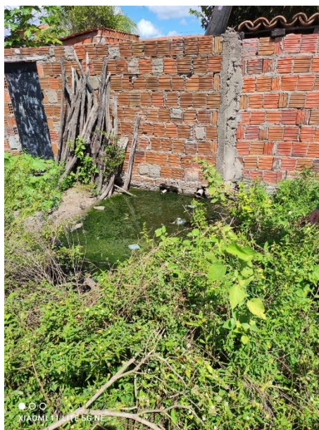
Figura 20: despejo de águas residuais diretamente ao solo, na aldeia Domingos Pereira (Crateús/CE)
