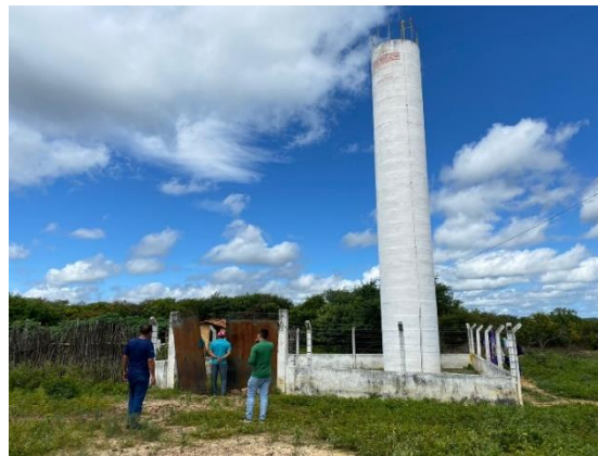
Figura 10: Reservatório elevado de SAA
