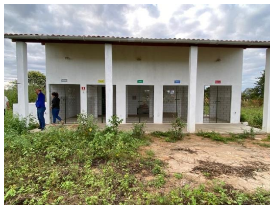
Figura 27: Baias para acomodação dos materiais por classificação
