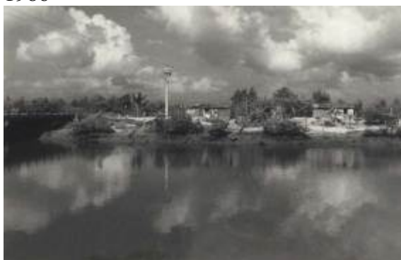
Fig. 34: Vista parcial da Ponte em 1986
