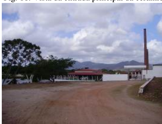
Fig. 16: Vista da entrada principal da cerâmica
