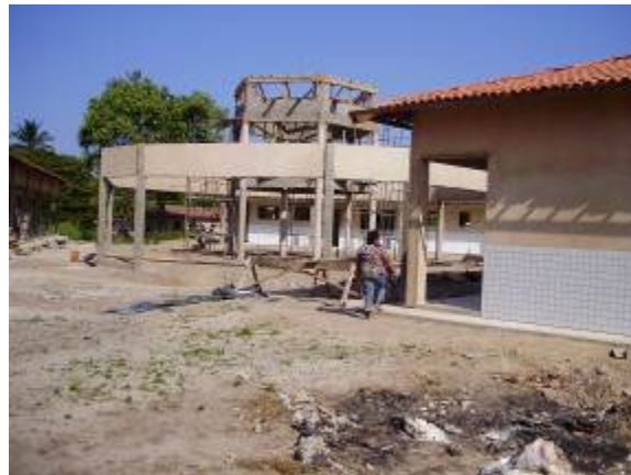
Fig. 41: Construção do novo prédio da escola do Trilho.
