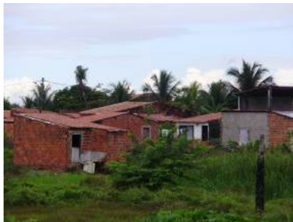
Fig. 39: Casas construídas na área retomada da Ponte
