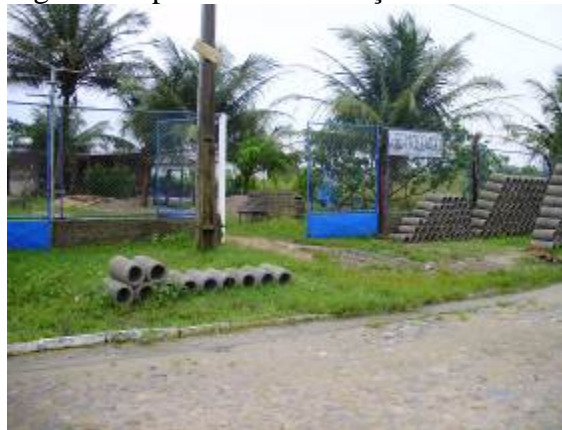
Fig. 33: Depósito de construção
