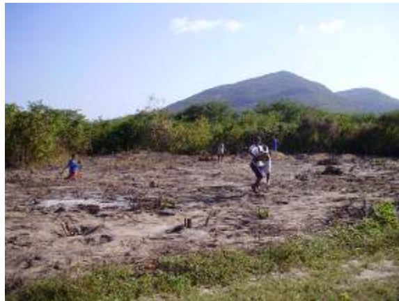
Fig. 53: Limpeza do terreno na retomada de 2009
