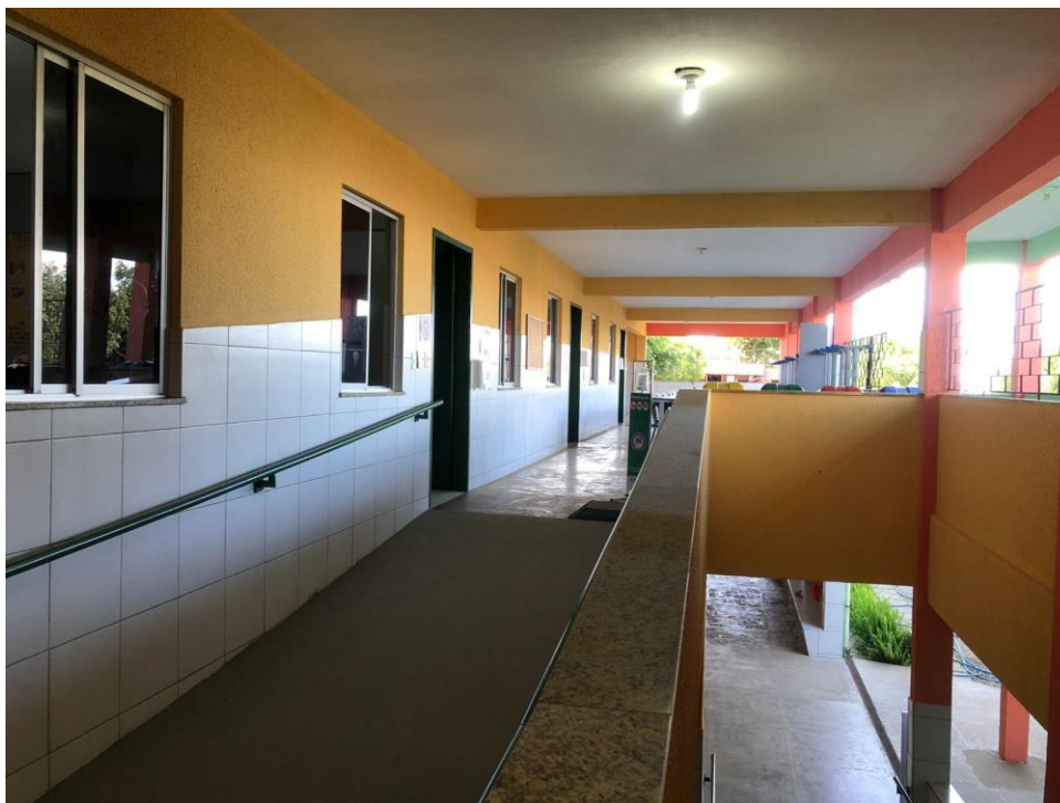
Figura 1 – Vista do piso superior da Escola Indígena Manoel Francisco dos Santos
