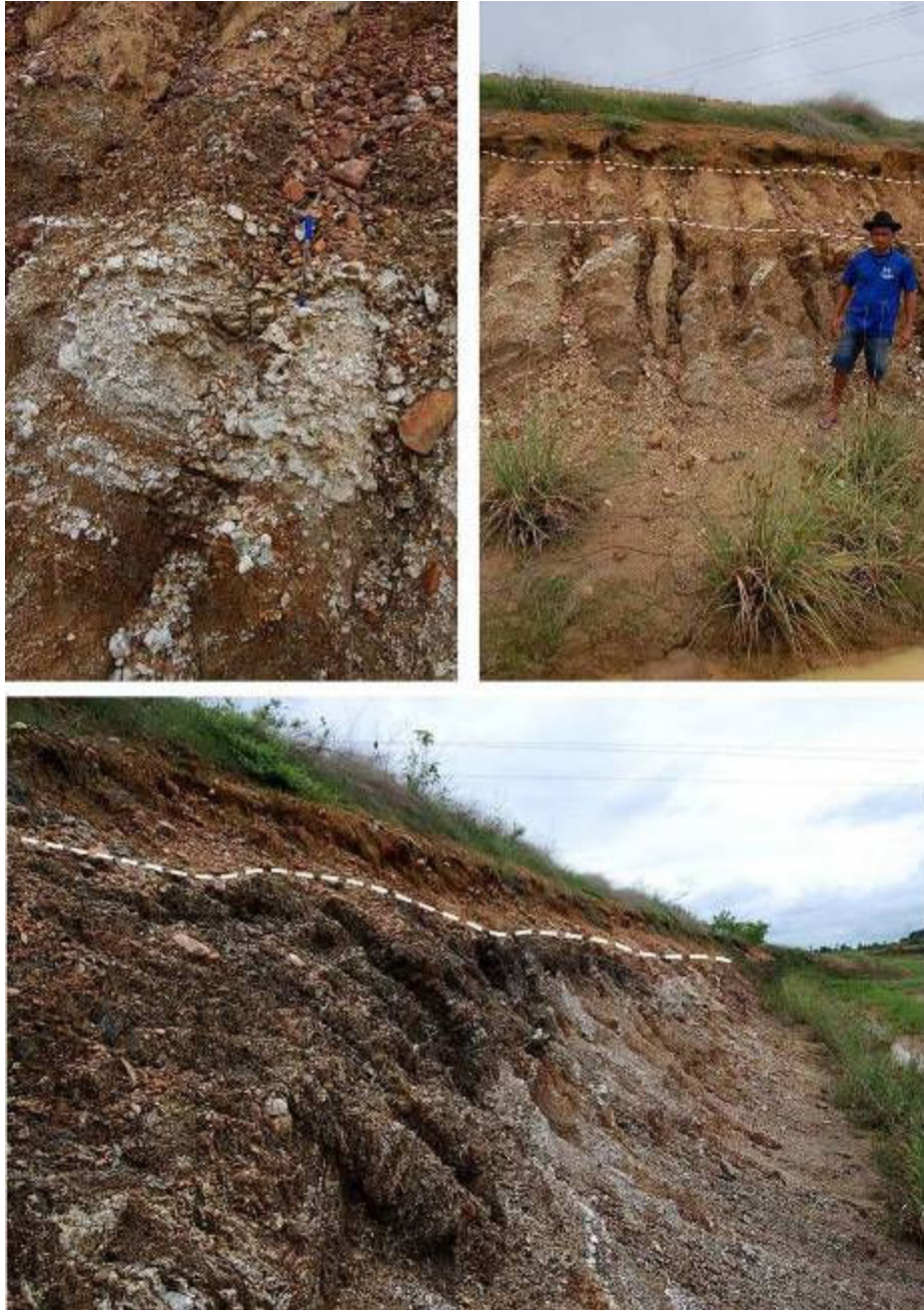
Figura 20 – Cortes na rocha para implantação do canal de adução Sítios Novos/Pecém. Rochas do embasamento cristalino denotando estreita camada de solo. Característica predominante da Depressão Sertaneja o que evidencia baixa capacidade pedológica e elevados índices de erosão do solo devido desmatamento e queimadas.
