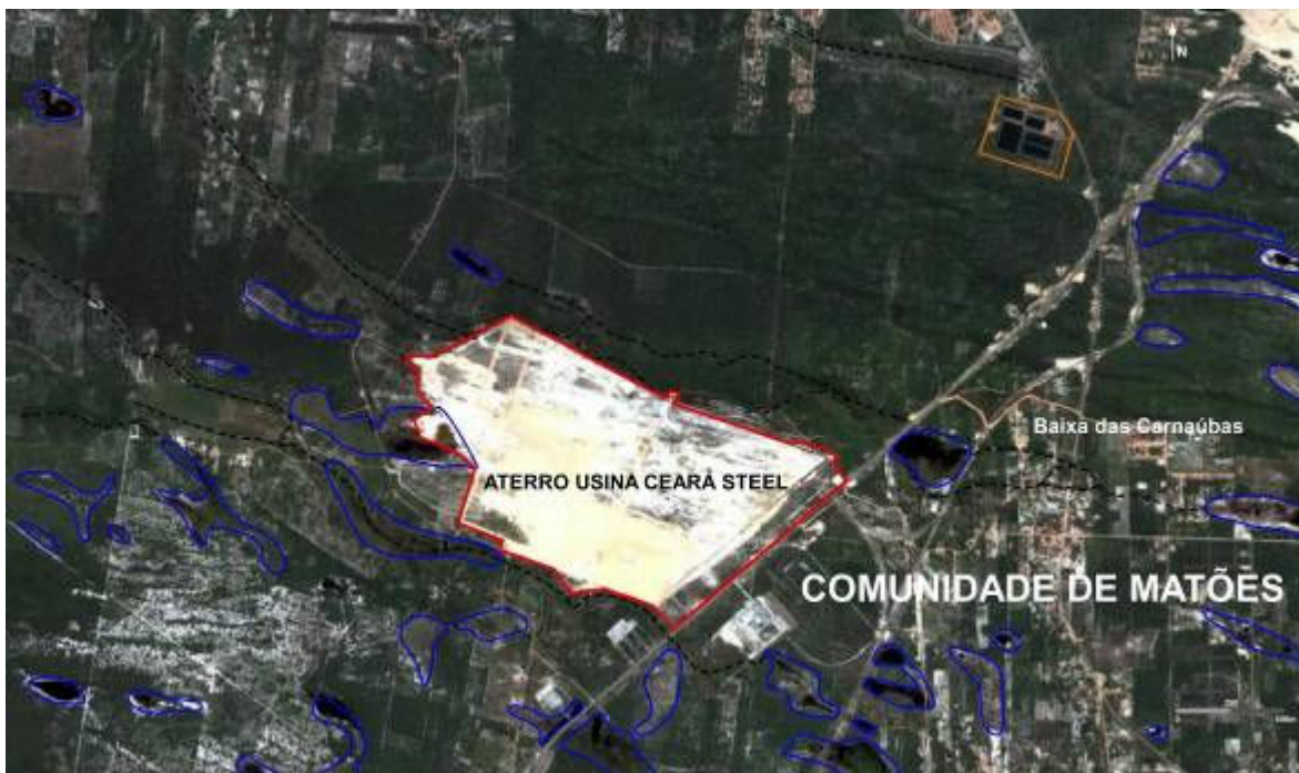
Figura 27 – Aterro e terraplenagem realizados em ambiente definido como Tabuleiro Pré-litorâneo. Atuou de modo a bloquear o fluxo de riachos e provocou a extinção de lagoas. Observar que o limite norte do aterro está em contato direto com as dunas fixas da área definida pelo Plano Diretor do CIPP como Estação Ecológica I. A figura também denota a interdependência entre os sistemas lacustres, interligados pelos pequenos riachos os quais são frequentemente utilizados para produção de alimento através do plantio de vazantes. No lado superior direito da imagem verificar a presença de várias lagoas interdunares.
