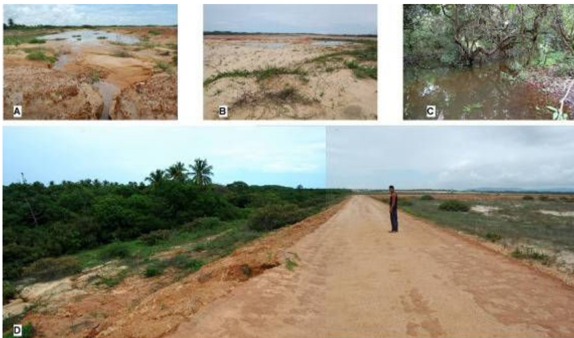
Figura 36 – Área desmatada e aterrada para instalação da Usina Ceará Steel (UCS). A erosão superficial está provocando a origem de voçorocas (A) com o material transportado para o interior dos riachos e lagoas localizados nas imediações. O desmatamento de dunas fixas promoveu a remobilização dos sedimentos arenosos (B). A fotografia C evidencia uma lagoa na área denominada Sete Galhos. Verificar que a área utilizada está em contato direto com o campo de dunas fixas (lado esquerdo da fotografia D). Para esta ação foram deslocadas famílias para assentamento. Antes utilizavam a potencialidade dos ecossistemas lacustre e das “levadas” para o plantio de roçados e vazantes, pesca e caça. Ações desta natureza (extinção e fragmentação de áreas úmidas) produziram impactos sócio-ambientais de elevada magnitude e, acumulados de acordo com o previsto pelo Plano Diretor do CIPP, incrementará os danos ao modo de vida tradicional indígena, produzindo riscos cumulativos à segurança alimentar e impactos negativos na qualidade e disponibilidade de água e da biodiversidade associada.
