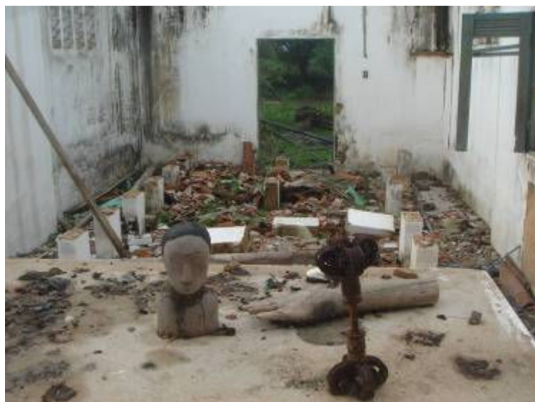
Figura 9 – A fachada da Capela de São Roque e seu interior demolido.
