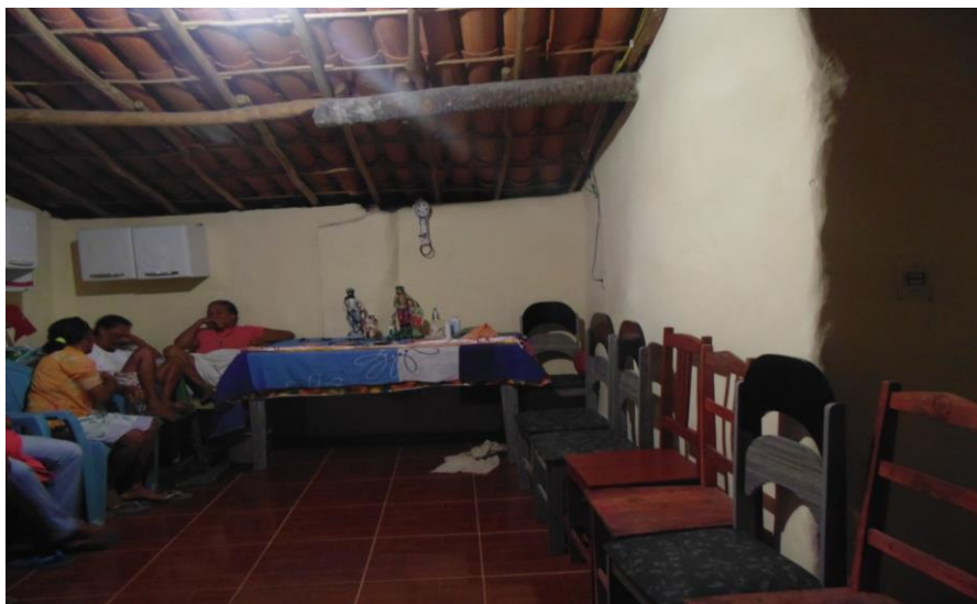
Figura 15: Trabalho numa casa em Telhas
