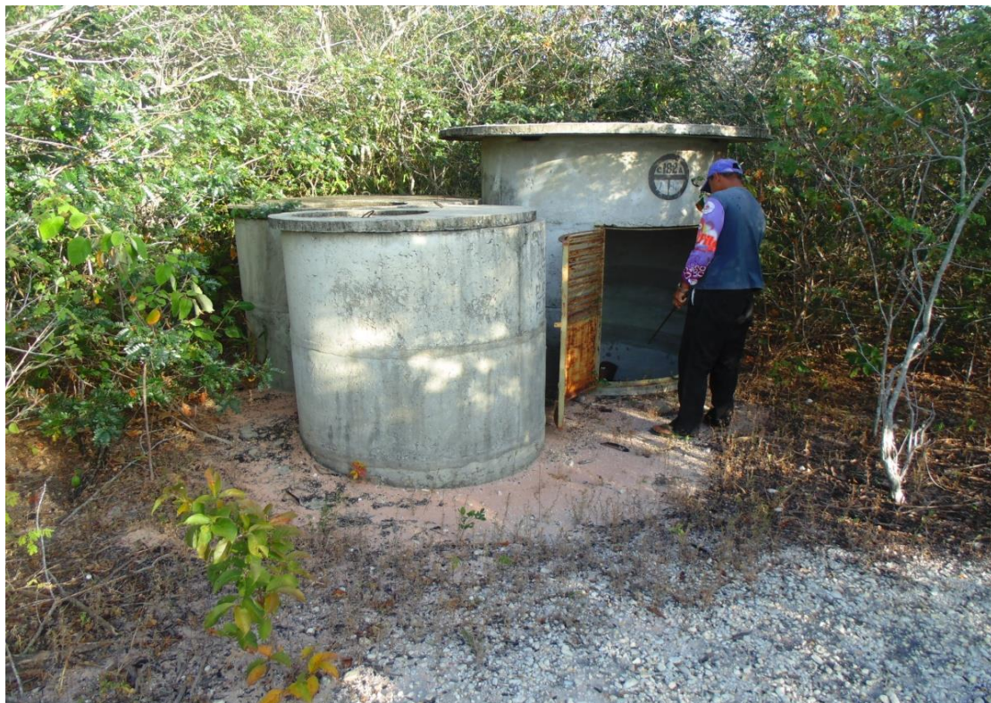
Figura 4: Caixas de concreto instaladas pelo DNOCS em um lugar dentro da Mata do Amargoso
