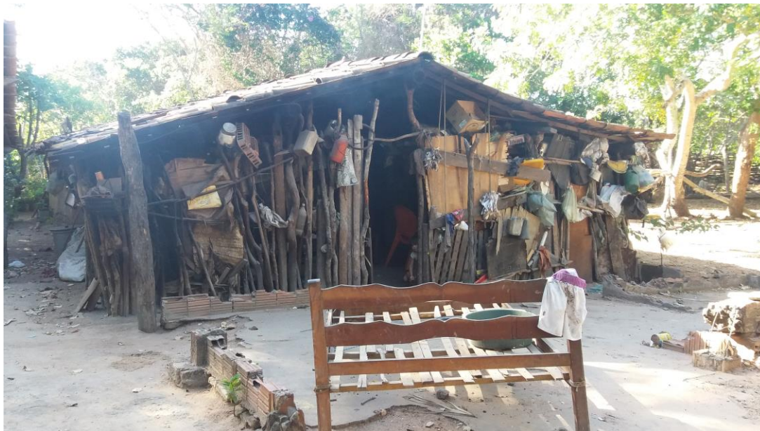
Foto 12 – detalhe da casa de Seu Antônio e Dona Lucia, com restos da construção da casa de farinha que foi destruída
