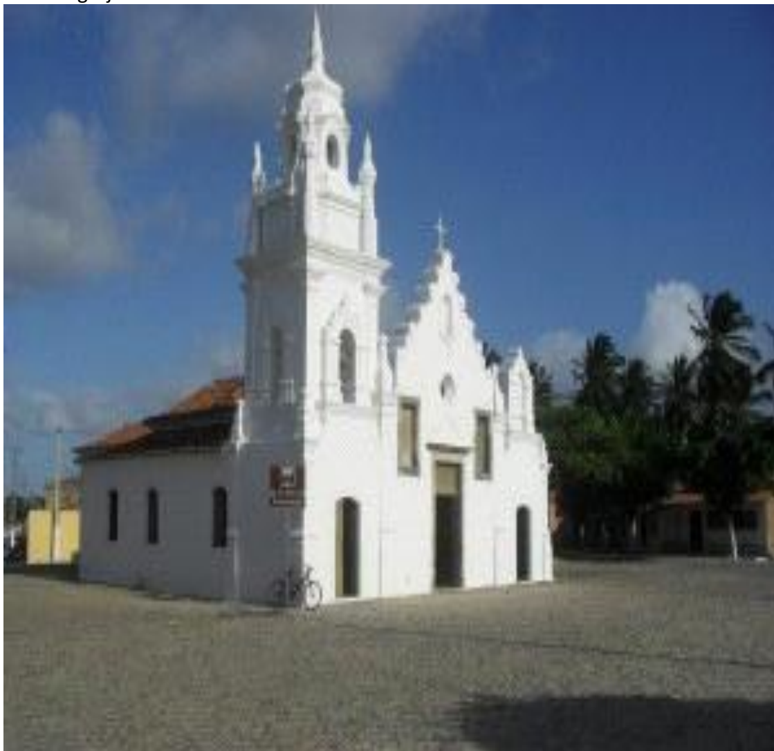
Foto 5: Igreja de nossa senhora de Almofala reformada
