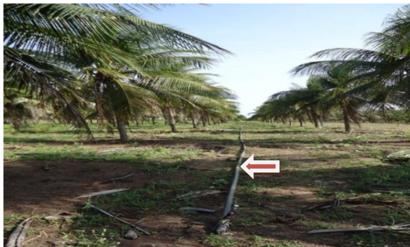
FIGURA 8. Sistema por micro-aspersão no cultivo de cocos em lote agrícola do Perímetro Irrigado Curu-Paraipaba
