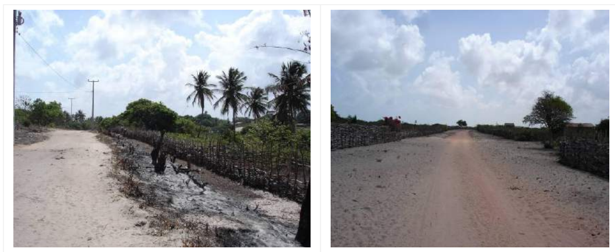
Figura 28: Estrada de acesso a TI Tremembé de São José e Buriti com sinal de vegetação queimada, deslocamento de cercas e acesso bastante alargado pelas margens desmatadas. Fotos: LUSTOSA, Isis Maria Cunha, jan., 2009.
