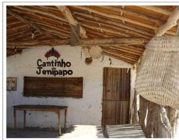
Figura 33: Palhoça “Cantinho do Jenipapo” concluída em 2010.
